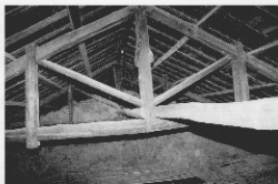
Dachstuhl einer ehemaligen Baracke
